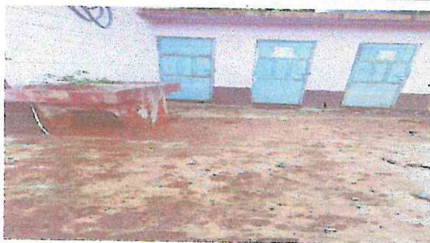
Foto 9. Torta de cemento que se abrirá por piso.
